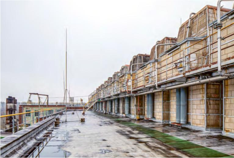
Abb. 5: Brikettfabrik Frechen-Wachtberg: Der obere Teil der Brüdenschlote auf dem Dach des Trockenhauses, Foto 2022.
