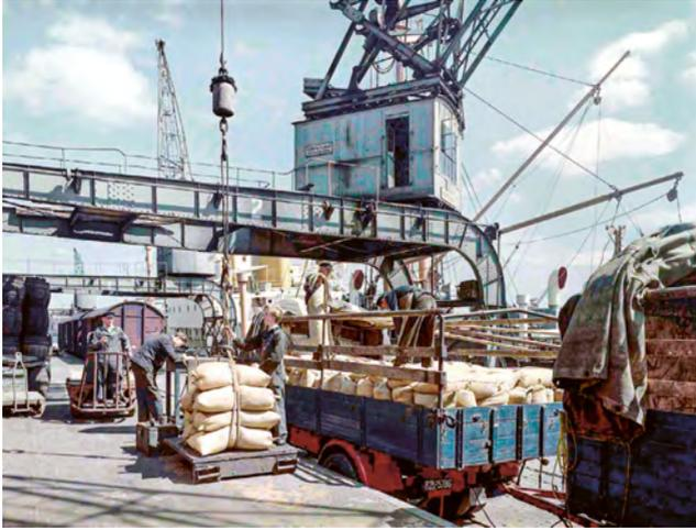
Abb. 1: Güterumschlag mit Halbportalkran im Freihafen, Hamburg, Foto 1957.
