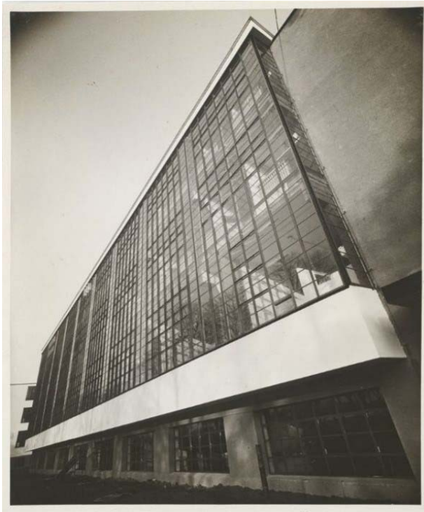
Abb. 1. Lucia Moholy, Bauhausgebäude Dessau, Werkstattfassade, 1926 (Bauhaus Archiv Berlin ©VG Bild-Kunst Bonn 2021)
