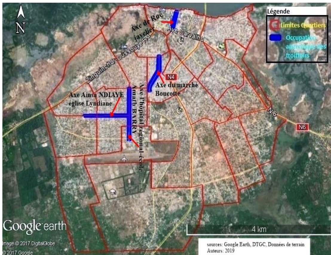
Figure 4. Les trottoirs et axes routiers les plus occupés informellement à Ziguinchor. Source : Auteurs, 2019
