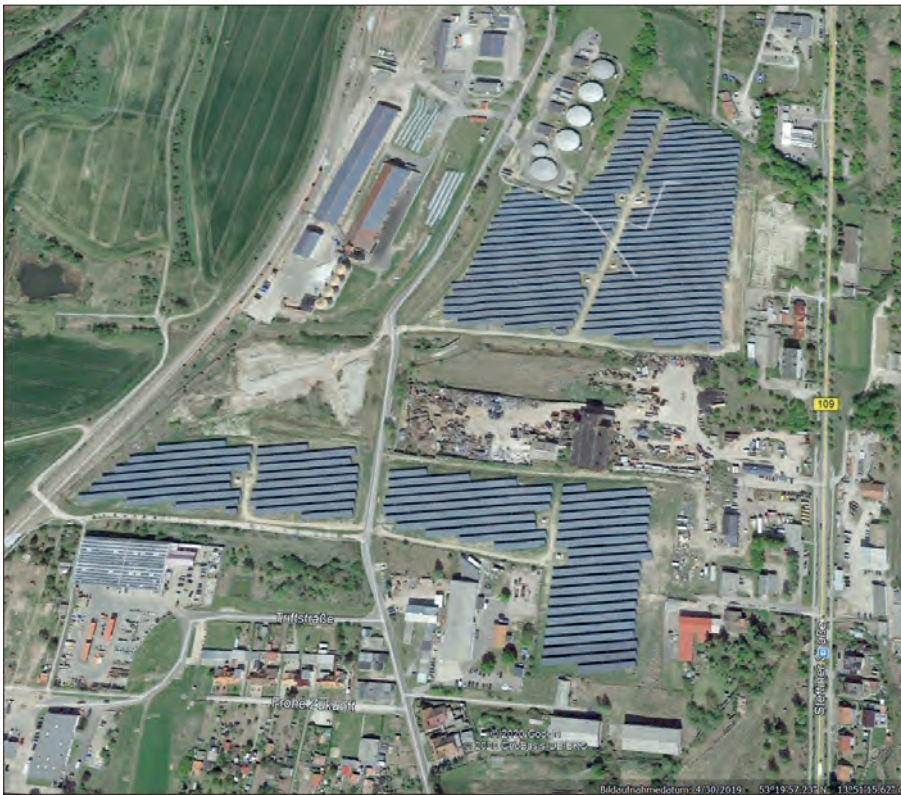
Abb. 1: Dimension der Photovoltaikfreiflächenanlage (PVA) auf dem ehemaligen Zuckerfabrikgelände in Prenzlau / Quelle: Google Earth
