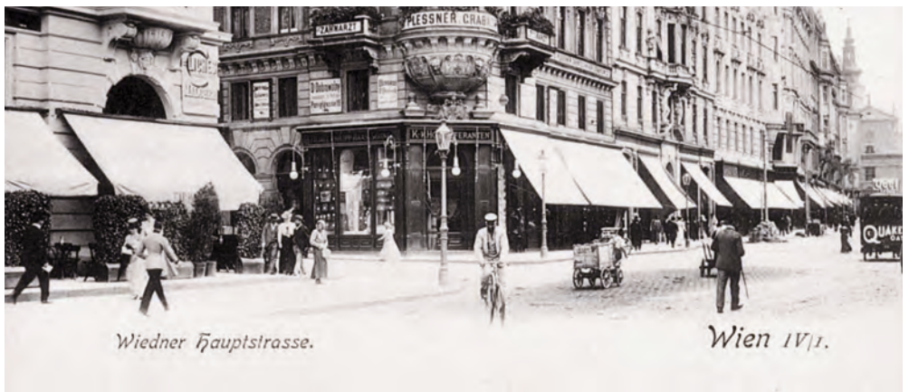
Abb. 5 Erdgeschossfassaden werden mittels flexibler Sonnenschutzplachen gestaltet. Quelle: https://akon.onb.ac.at/#id=AKON_AK037_408 (15.11.2023)
