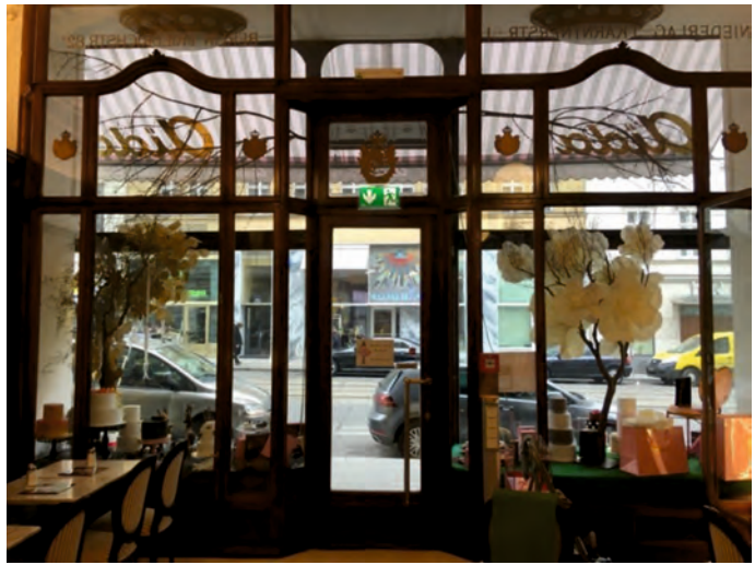
Abb. 6 Portale, Holz-Glas-Konstruktionen, die der eigentlichen Erdgeschossfassade vorgesetzt sind und den Austausch zwischen innen und außen in Szene setzen © Psenner 2020
