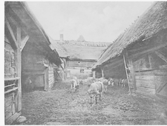
Abb. 4. Brennerei in Kirche (Hofansicht, von der Scheune aus gesehen).
