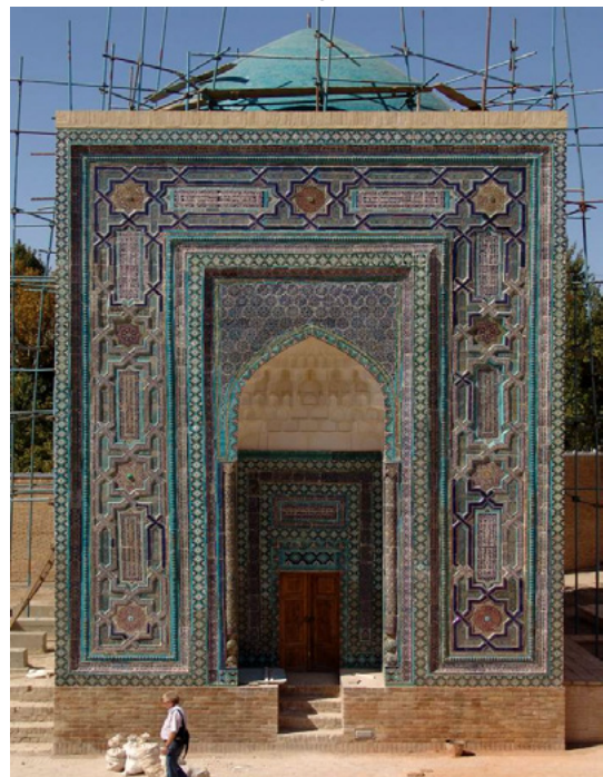
Abb. 4: Zustand 2007 nach abgeschlossener Generalrekonstruktion. Im Vergleich zu Abb. 3 ist der große Umfang an Ergänzungen mit Glasur-Keramik gut auszumachen
