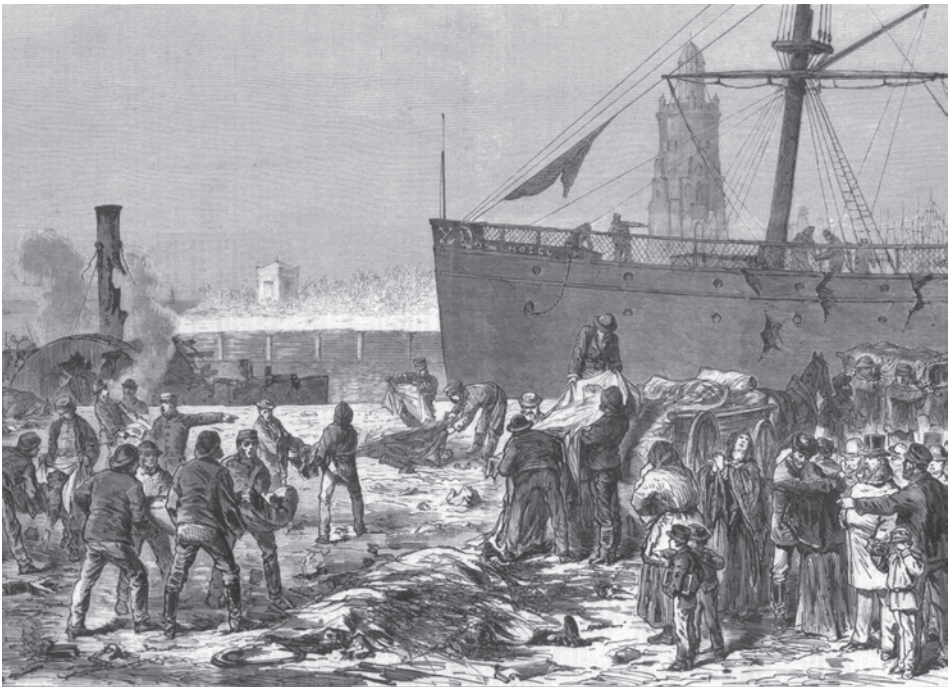
Abb. 2 Der Kai an der Schleuse zum Neuen Hafen unmittelbar nach der Explosion. (Holzstich nach H. Marutzky in der Illustrierten Zeitung, Nr. 1696, 1.1.1876, S. 13)
