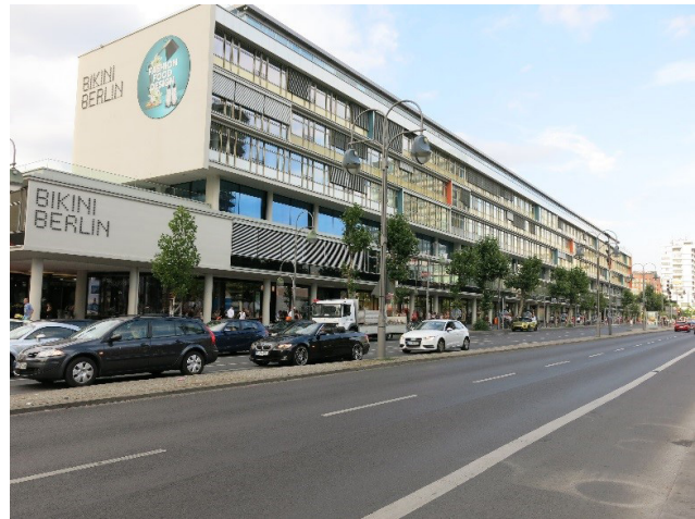
Abbildung 1: Gebäudekomplex Bikini Berlin an der Budapester Straße
