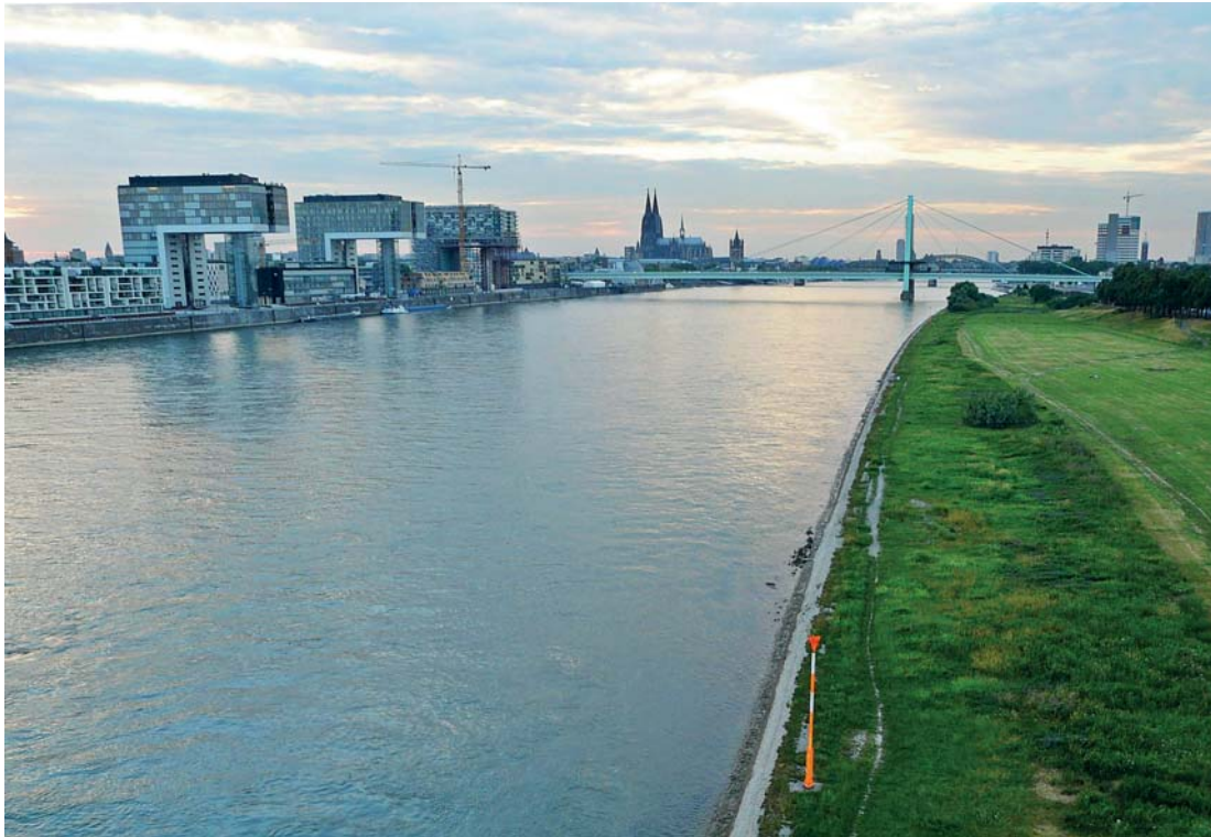
Abbildung 2: Der Kölner Rheinauhafen – neues, multifunktionales Quartier am Wasser
