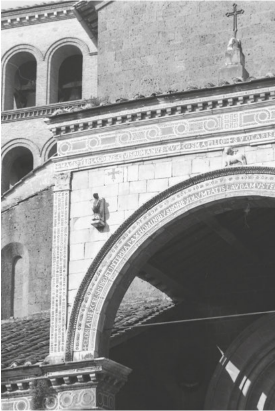
Abb. 19: Civita Castellana, Duomo, Portikus vor der Westfassade, Inschrift auf dem Bogenlauf und dem Architrav des Mittelteils.
