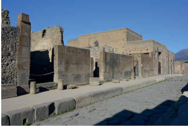
Abb. 66: Casa della Fontana Grande (VI 8,22), Quaderfassade.
