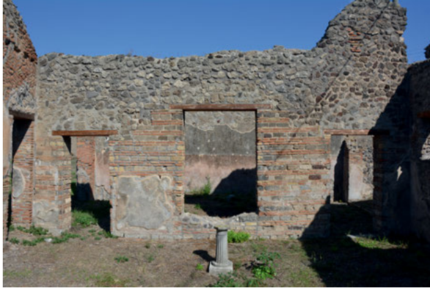
Abb. 316: Casa di P.L.F. (IX 6,3), Blick auf die Atriumsrückwand, die den Übergang zu Garten (f) herstellt.
