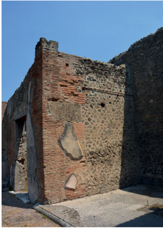
Abb. 32: Casa del Fauno, Ostia (24/14), mit erhöhter Schwelle, eingefasst durch Pilaster mit Sofakapitellen.
