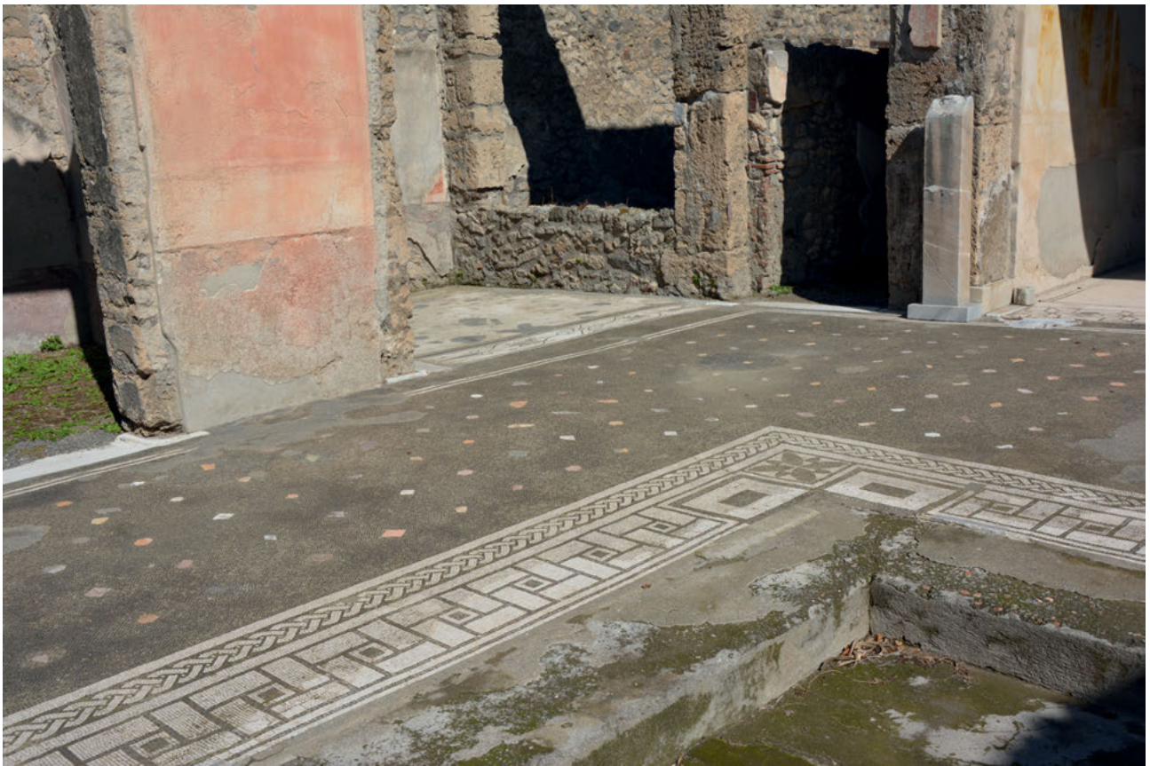
Abb. 376: Casa di L. Caecilius Iucundus (V 1,23.26), Blick über das Impluvium und das schwarze Mosaik des Atriums, in das Marmorplättchen eingesetzt sind, hinweg, in Richtung Nordala.
