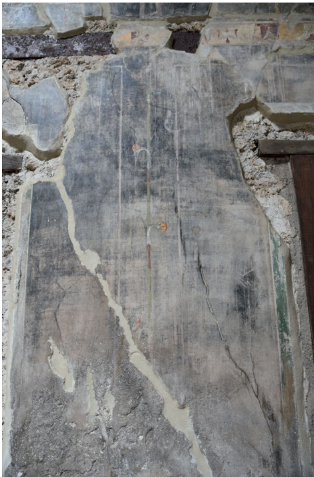
Abb. 285: Casa di Marcus Lucretius Fronto, Westseite des Atriums, Wandabschnitt zwischen den Räumen (e) und (c) mit Rankenpfeiler.
