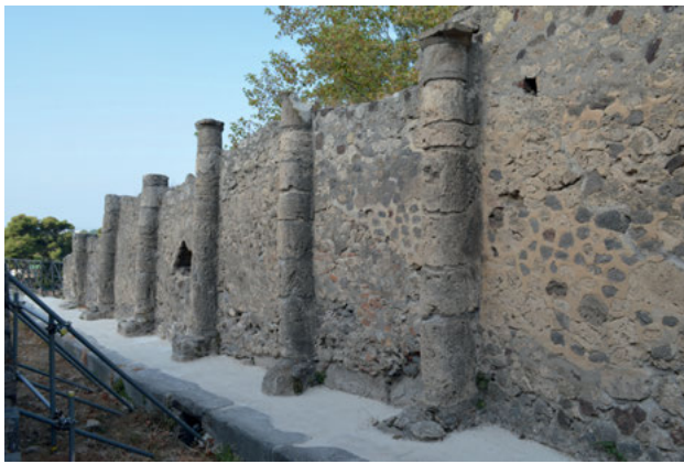
Abb. 67: Vicolo dei Soprastanti, durch Halbsäulen strukturierte Außenwand.
