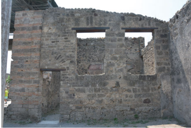
Abb. 58: Casa del Fauno, Triclinium (31/44), Ansicht vom Peristylumgang.
