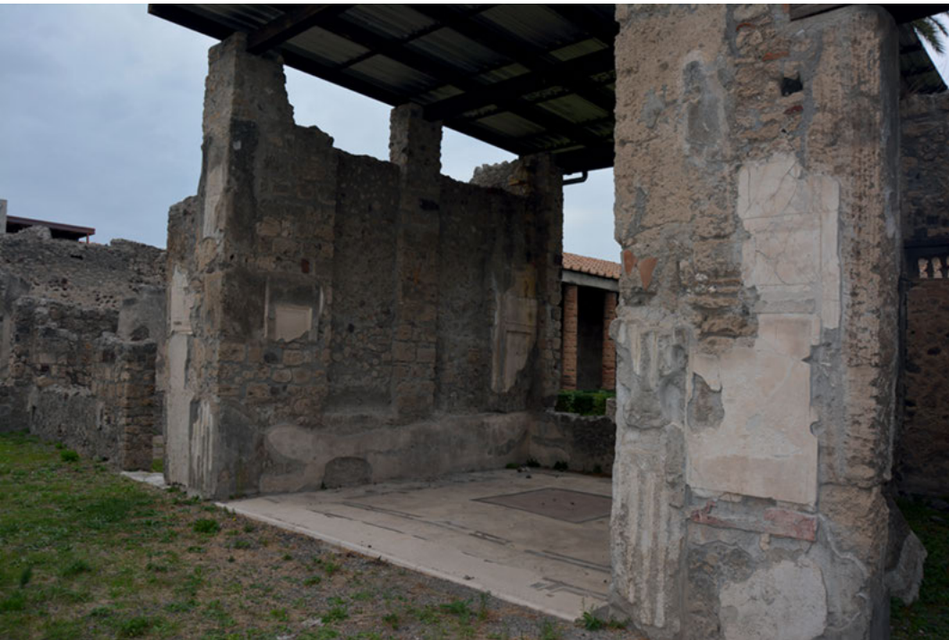
Abb. 137: Casa del Labirinto, Blick in das von Pilastern gerahmte Tablinum; rechts des rechten Tablinumpilasters ist die Atriumsrückwand im ersten Stil erhalten.
