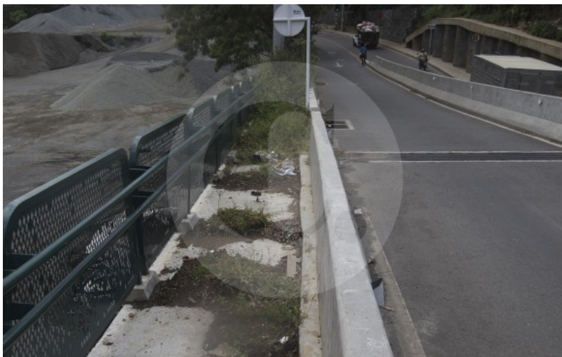
Figura 28. Andén peatonal Puente Madre Laura Fuente: (Zuluaga, 2017)
