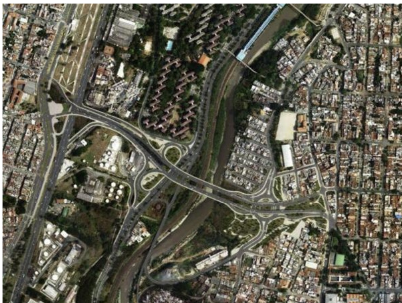
Figura 23. Panorámica Puente Madre Laura Montoya
