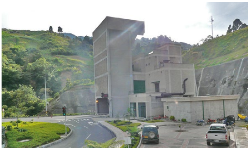
Figura 29. Fotografía de inicio del Túnel de Occidente
