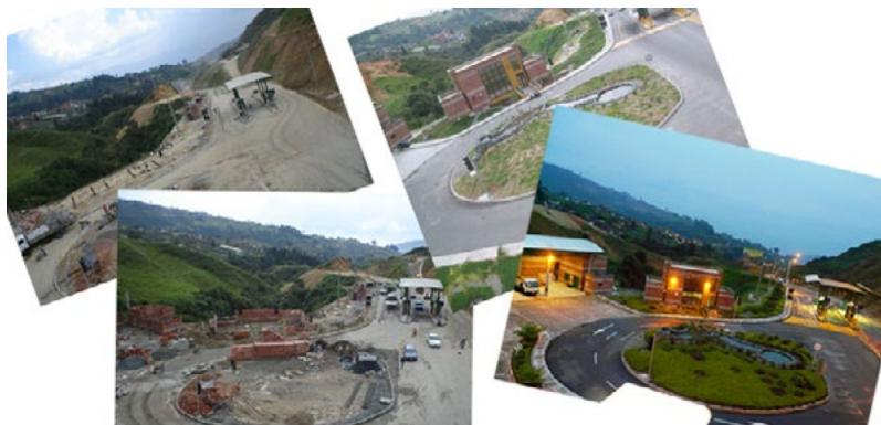
Figura 30. Fotografía "Collage" sobre avances de la construcción del Túnel de Occidente. Fuente: Túnel Fernando Gómez Martínez (2013)
