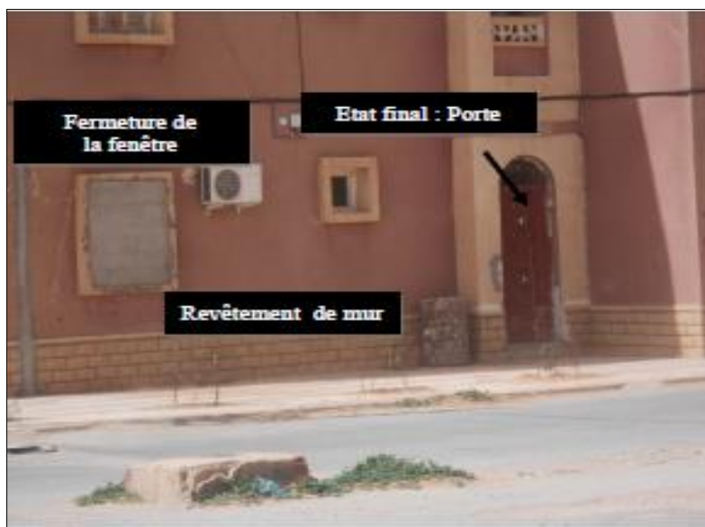
Figure 21. L'état final après transformation d'un logement d'habitat collectif en une habitation individuelle (Auteurs, mars 2017)
