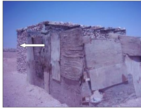
Figure 7. Le passage progressif de la baraque en bois vers la construction en pierre (Source : auteurs – juillet 2009)
