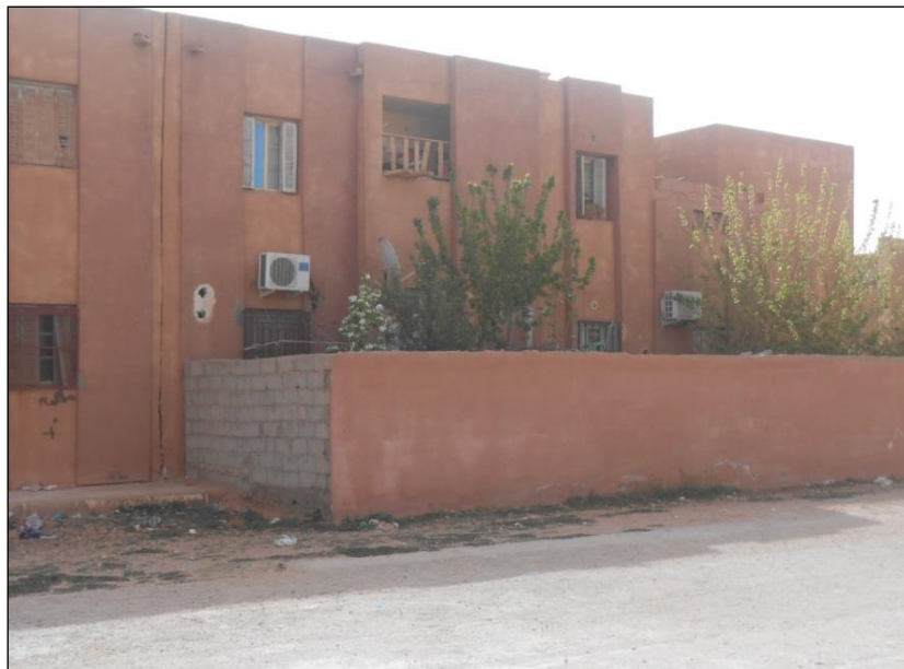
Figure 18. Rajout d'une cour et un jardin au logement en occupant la voie publique (Auteurs septembre 2017)
