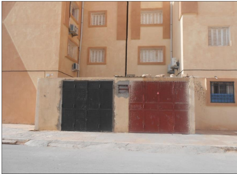
Figure 19. Construction d'un espace pour stationnement de voiture en occupant la voie publique (Source : Auteur, mars 2017)
