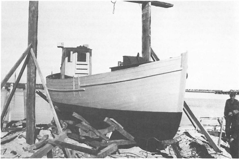
Abb. 21 Der erste Kutter mit Kraweelbeplankung, gebaut von F. Ledke aus Władisławowo im Jahre 1950. (Archivaufnahme, Slg. Litwin)
