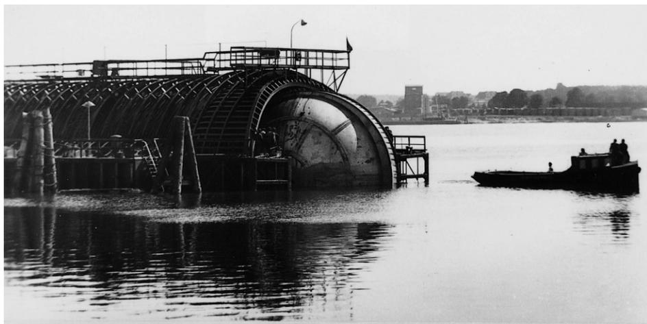
Abb. 13–14 Prüfdock für U-Boote, gebaut 1938 von den Lübecker Flenderwerken für die Deutsche Kriegsmarine. Die Bilder zeigen das Dock in geöffnetem Zustand und beim Einbringen des Verschlusskörpers.
