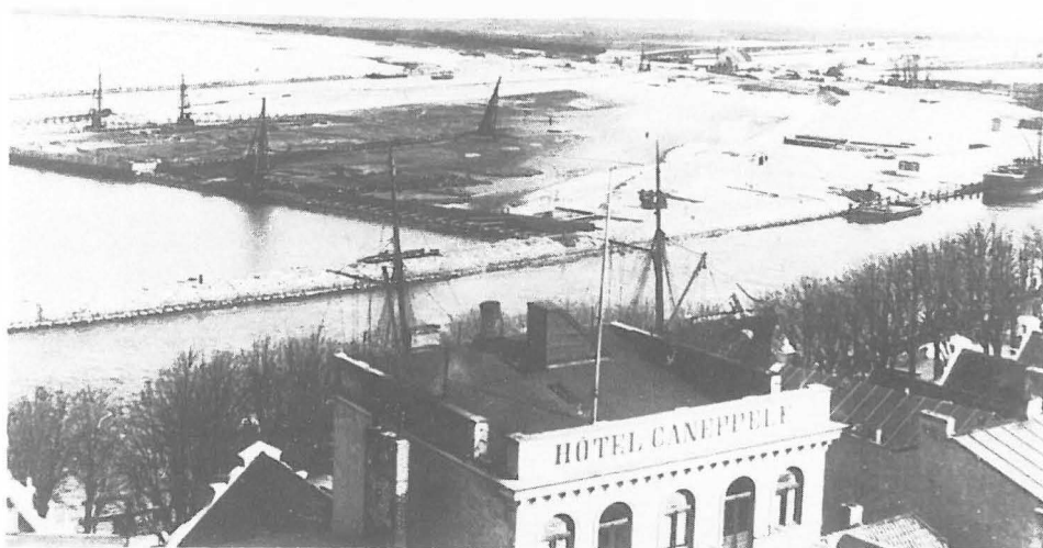
Oben: Blick vom Warnemünder Leuchtturm in östliche Richtung. Hinter dem Hotel die alte Mündung der Warnow, der »Alte Strom«, im Hintergrund der neue Fahrwasserdurchstich, der »Neue Strom«; dazwischen das Baugelände der geplanten Fähranlagen. Dampfmaschinen setzen gerade die Spundwände der Fährbetten (Foto: Slg. Pieplow). – Unten: Der gleiche Blick in den dreißiger Jahren (Foto: Schäfer)
