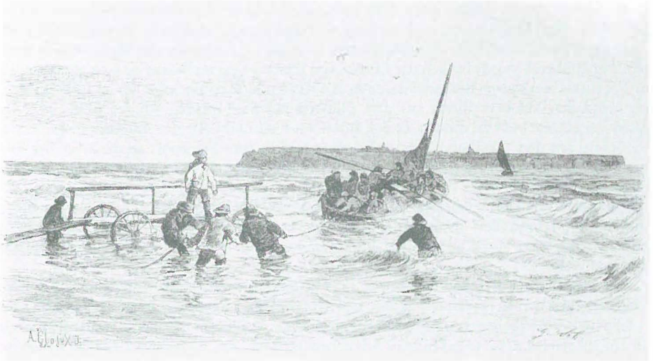
Abb. 9 Helgoland. Fahrbarer Anlegesteg für Boote, die Badegäste zur Düne bringen (1880). Nach E. Hoefler.
