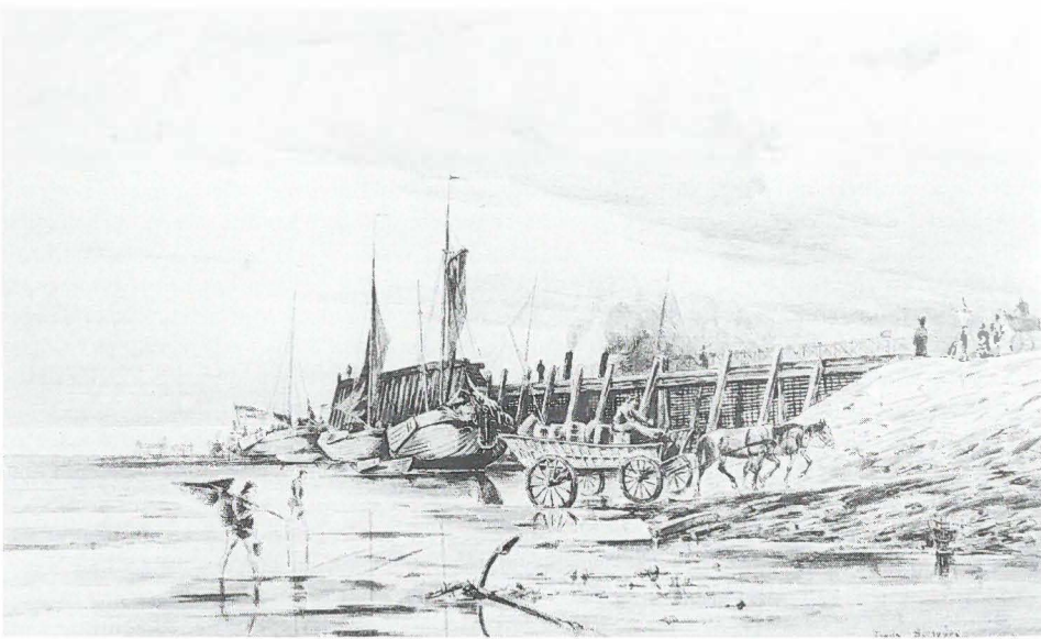
Abb. 4 Norderney. Zwei Hafensysteme nebeneinander: die alte Methode mit Pferdewagen neben trockengefallenen Tjalken und die neue Methode mit der hohen Anlegebrücke zum Abfertigen der Seebäder-Dampfer – hier bei Ebbe (um 1900). Nach F. Schreyer.
