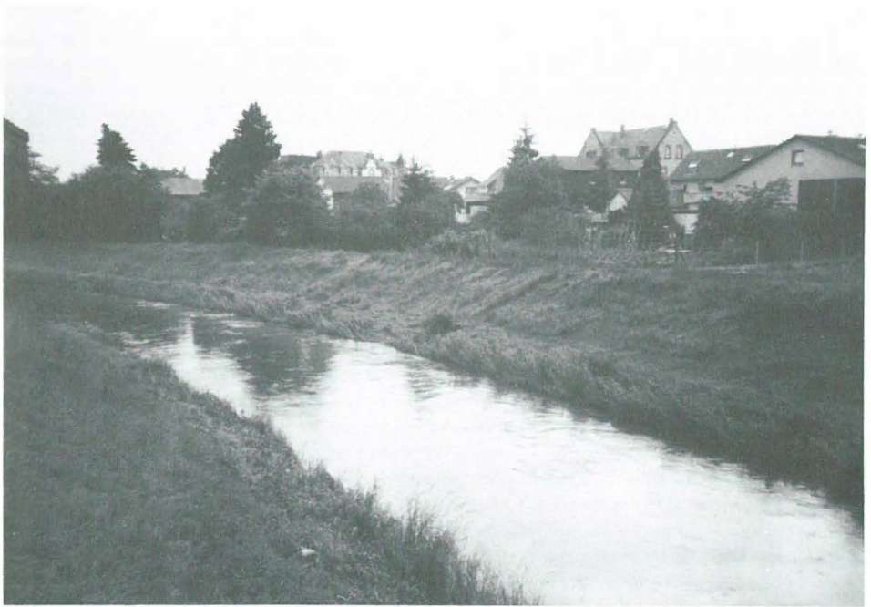
Abb. 11 Nidda bei Okarben, von der Straßenbrücke flussabwärts. Aufn. 1985
