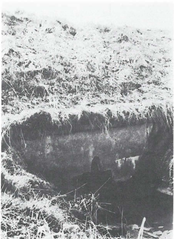
Abb. 5 Damm des Speyerbachs in Dudenhofen mit Unterführung des Wooggrabens. Aufn. 1980
