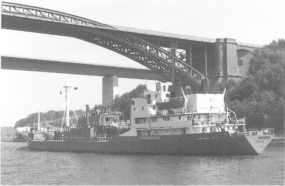
Abb. 17 Hochbrücken in Levensau (Kreis Rendsburg-Eckernförde, 1991).
