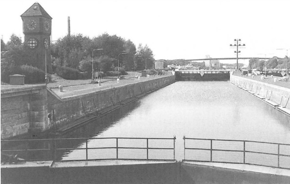
Abb. 12 Südkammer der Alten Schleusen in Kiel-Holtenau (1992).
