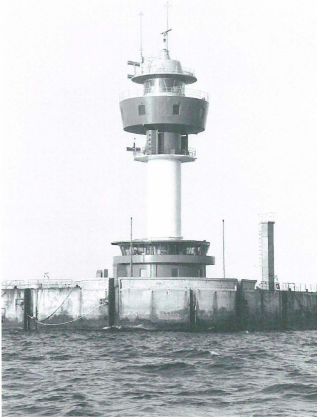
Abb. 32 Leuchtturm KIEL mit Lotsenstation in der Außenförde (1992).
