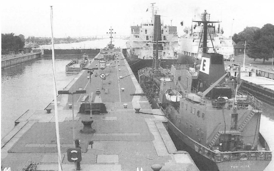
Abb. 15 Neue Schleusen in Brunsbüttel (1988).
