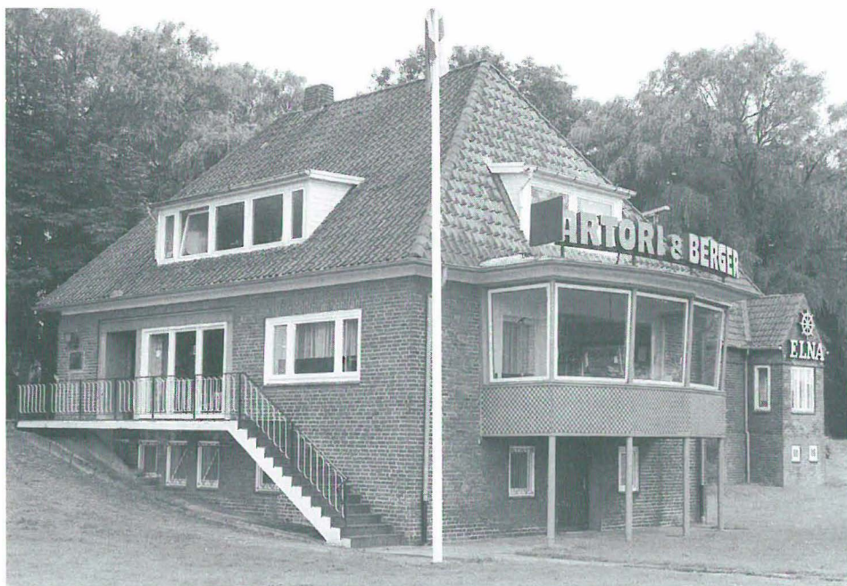
Abb. 34 Dienstgebäude an den Neuen Schleusen in Brunsbüttel (1988).
