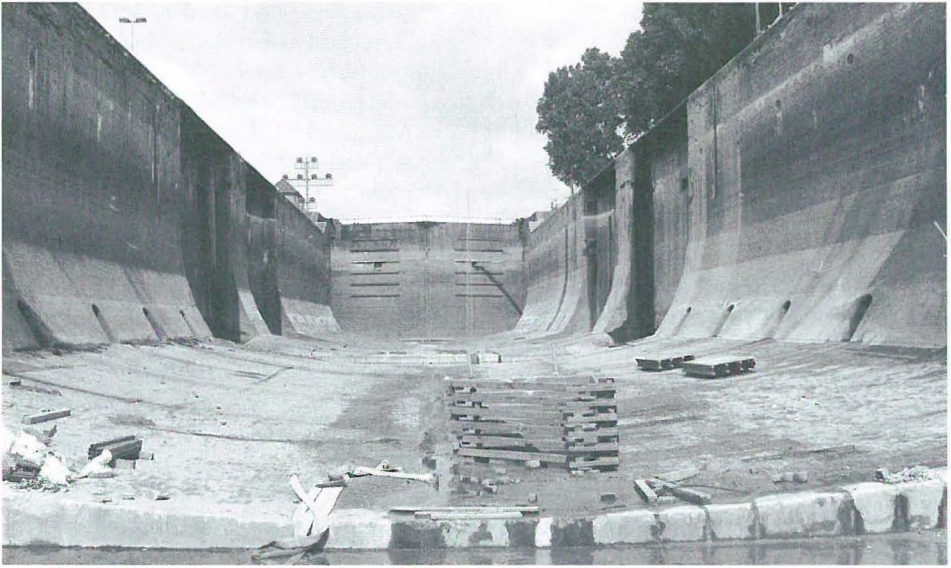
Abb. 13 Südkammer der Alten Schleusen in Brunsbüttel (1988).
