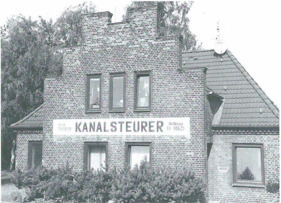
Abb. 30 Station der Kanalsteuerer an den Alten Schleusen in Kiel-Holtenau (1992).
