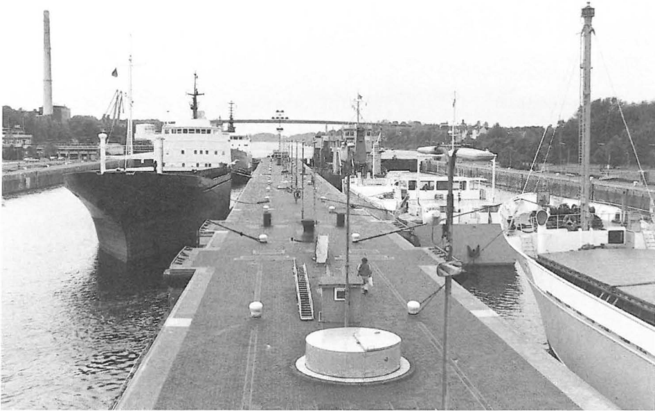
Abb. 14 Neue Schleusen in Kiel-Holtenau (1992).
