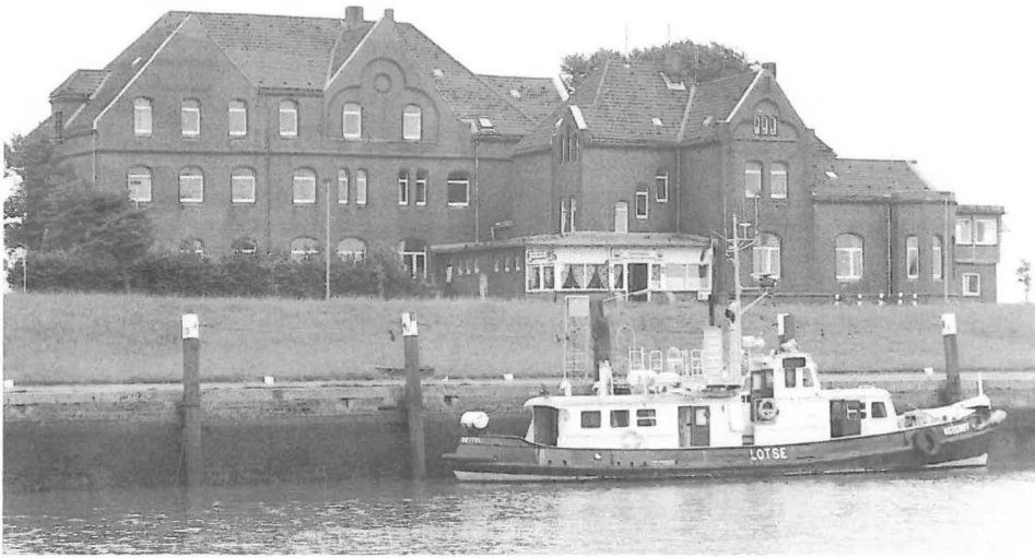
Abb. 31 Lotsenstation mit Lotsenversetzboot OSTERIFF in Brunsbüttel (1988).
