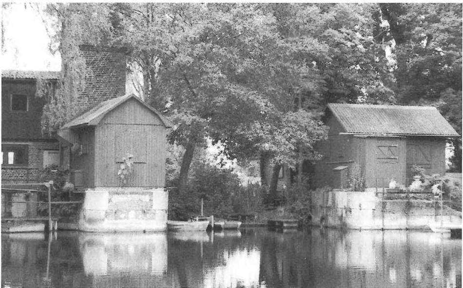
Abb. 1 Schleuse des Schleswig-Holsteinischen Kanals bei Klwensiek (Kreis Rendsburg-Eckernförde, 1987).
