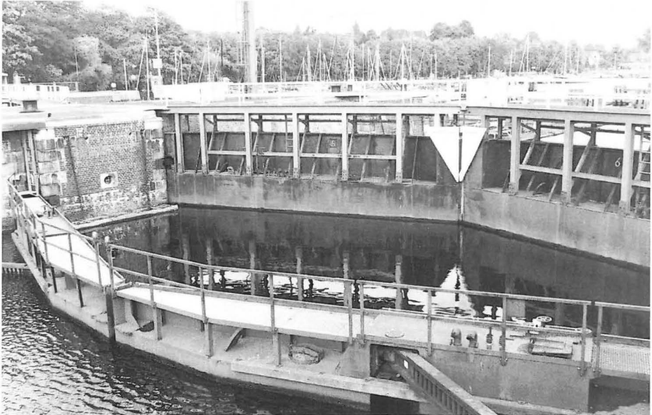
Abb. 8 Stemmtore am Binnenhaupt der Südkammer in Kiel-Holtenau (1992).
