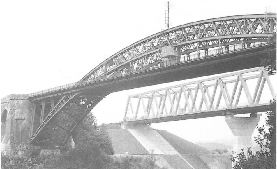
Abb. 18 Hochbrücken in Grüental (Kreis Rendsburg-Eckernförde, 1986).
