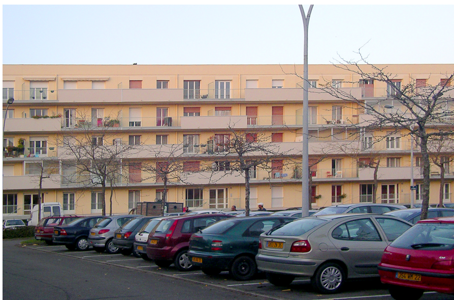
Foto 6: Renovierter Privatwohnraum im Sektor Nordwest
