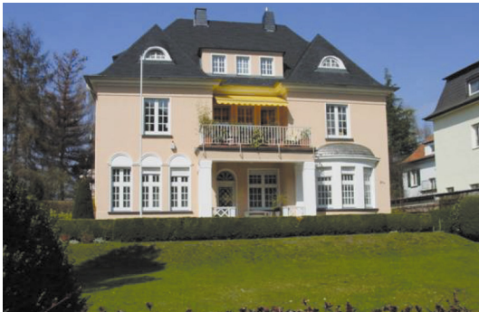
Abb. 23: Villenbebauung in Bad Godesberg
