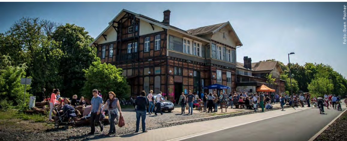
Der historische Mirker Bahnhof in Wuppertal
