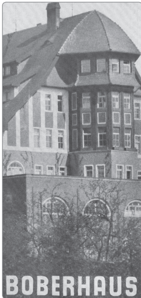
Abbildung 1: Ansicht der südwestlichen Seite des Boberhauses im Prospekt von 1930 1
