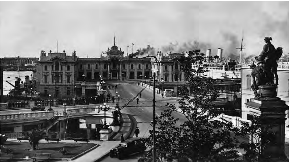
Abb. 12a Blick auf Genuas Stazione Marittima di Ponte dei Mille: deren Obergeschosse der landseitig-repräsentativen Empfangsgebäudefront; italienisches Foto nach 1930; DSM. (Stiftung 2000) – Dort überstand der Autor, unter Beschuß durch leicht bewaffnete, in den Bergen oberhalb Genuas stationierte, italienische Befreiungseinheiten, seine drei letzten Kriegstage.
