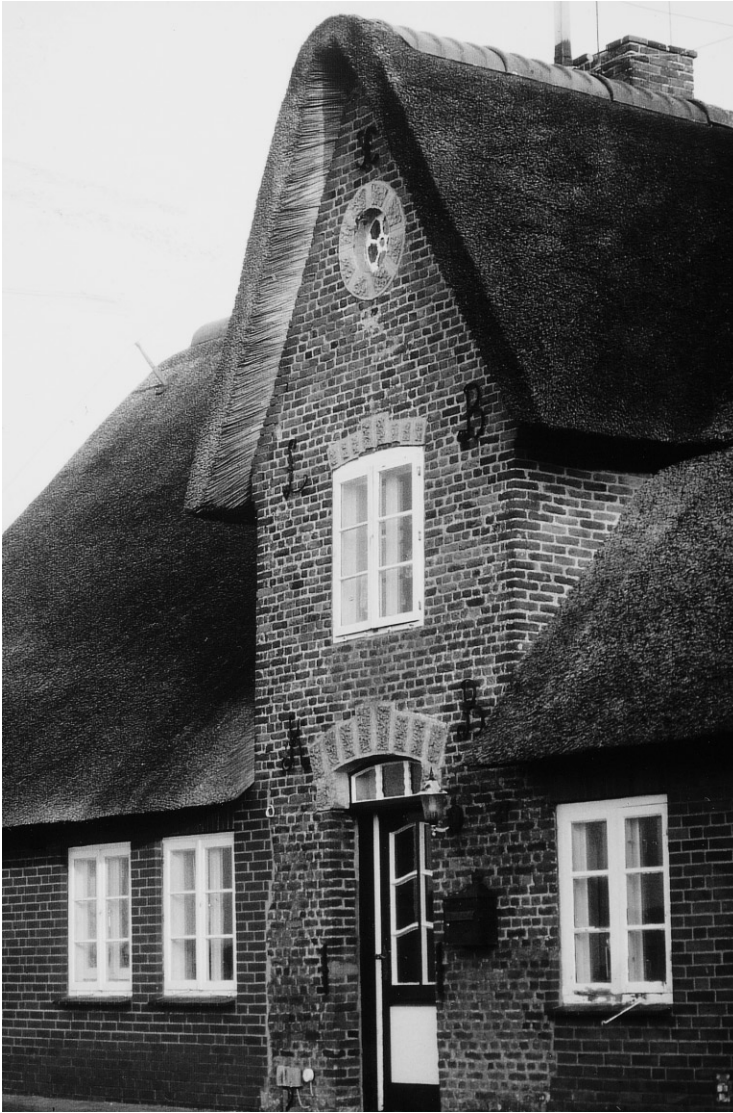
Abb. 2 Das Haus von Boy Lorentz Petersen in Mosum, Ortsteil Wall. Das Gebäude trägt in seinem Giebel die Maueranker-Buchstaben »LB« und »KB« und auf der Westseite die Ziffern »1787«. Die Ziffern und Buchstaben müssen nicht zwangsläufig aus der Errichtungszeit des Hauses stammen, die Buchstaben stehen sicher mit den Namen früherer Hausbesitzer in Verbindung, aber nicht unbedingt mit B.L. Petersen. Das Haus ist wahrscheinlich älter als 1787. (Foto: B. Pflüger)
