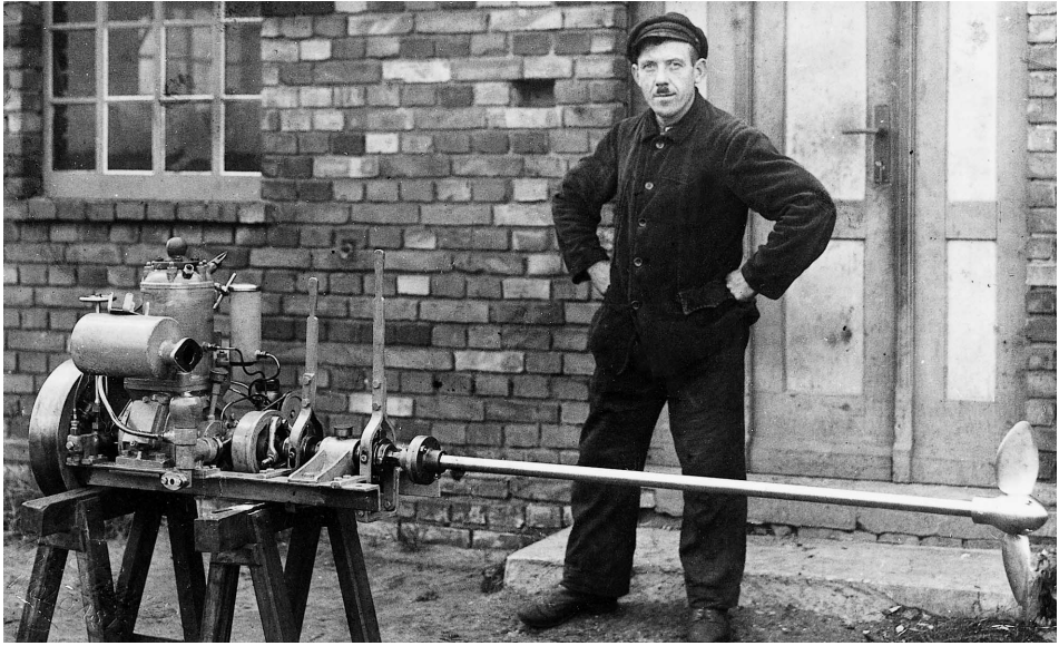
Abb. 6 Hafenschmied Arthur Paeschke weist seinen ersten selbstgebauten Glühkopf-Bootsmotor vor (1928).
