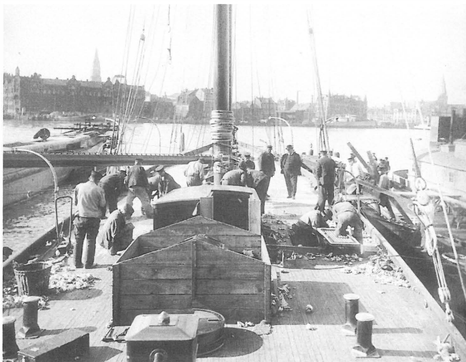
Abb. 31 METEOR (V), Deckhobeln, Kiel 24. April 1914
