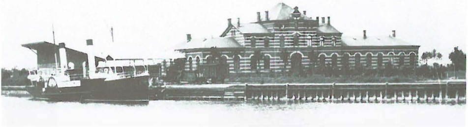
Das Bahnhofsgebäude des Deutsch-Nordischen Lloyd in Warnemünde (Foto: Eschenburg)
