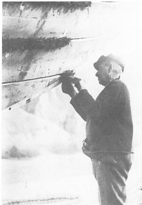
Abb. 18 Als Dichtung wird Moos (süddeutsch: Mias) in die Kalfatnähte gepreßt.
