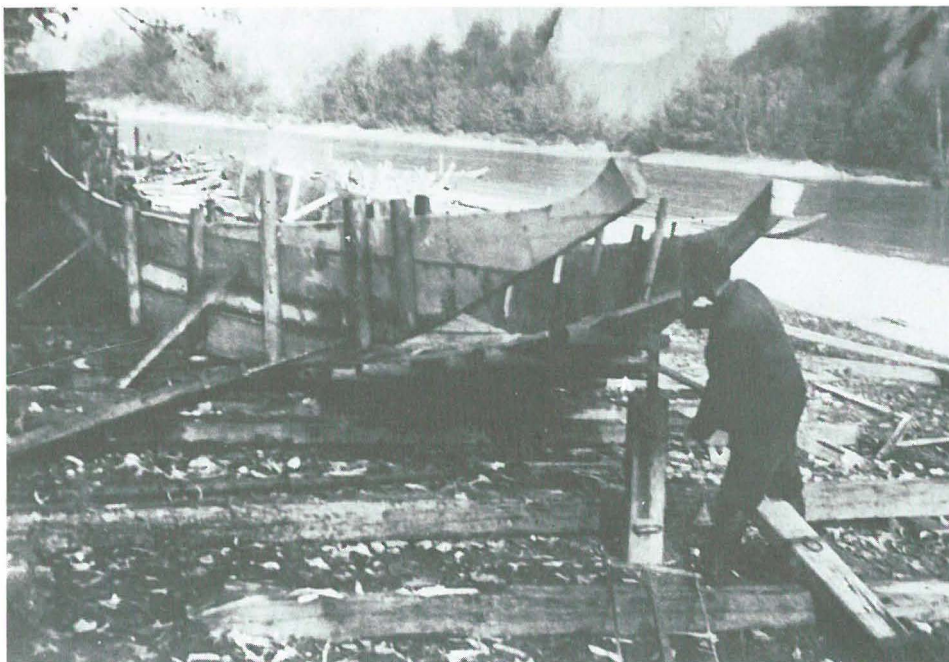
Abb. 8 Boden und Seiten werden mit der Winde zueinandergebogen.
