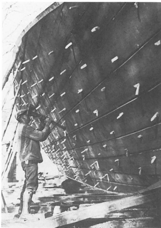
Abb. 15 Die Holznägel werden verkeilt.
