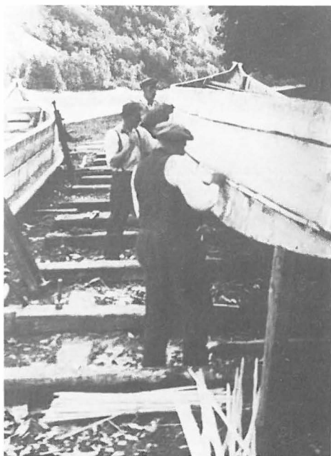
Abb. 20 Die Kalfatnaht wird mit einer Leiste (süddeutsch: Zain) abgedeckt.
