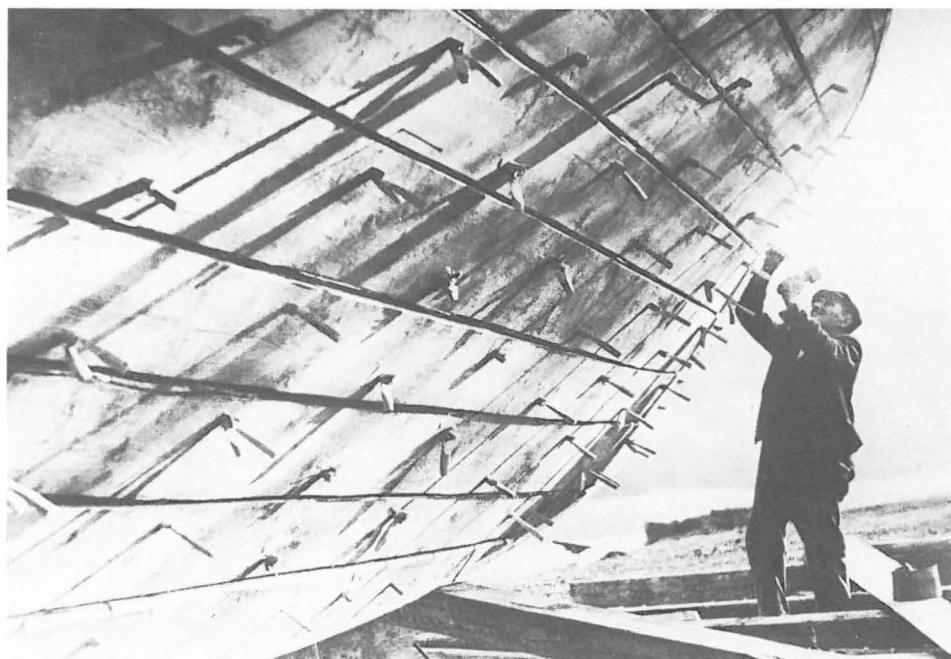
Abb. 15 Die Holznägel werden verkeilt.
