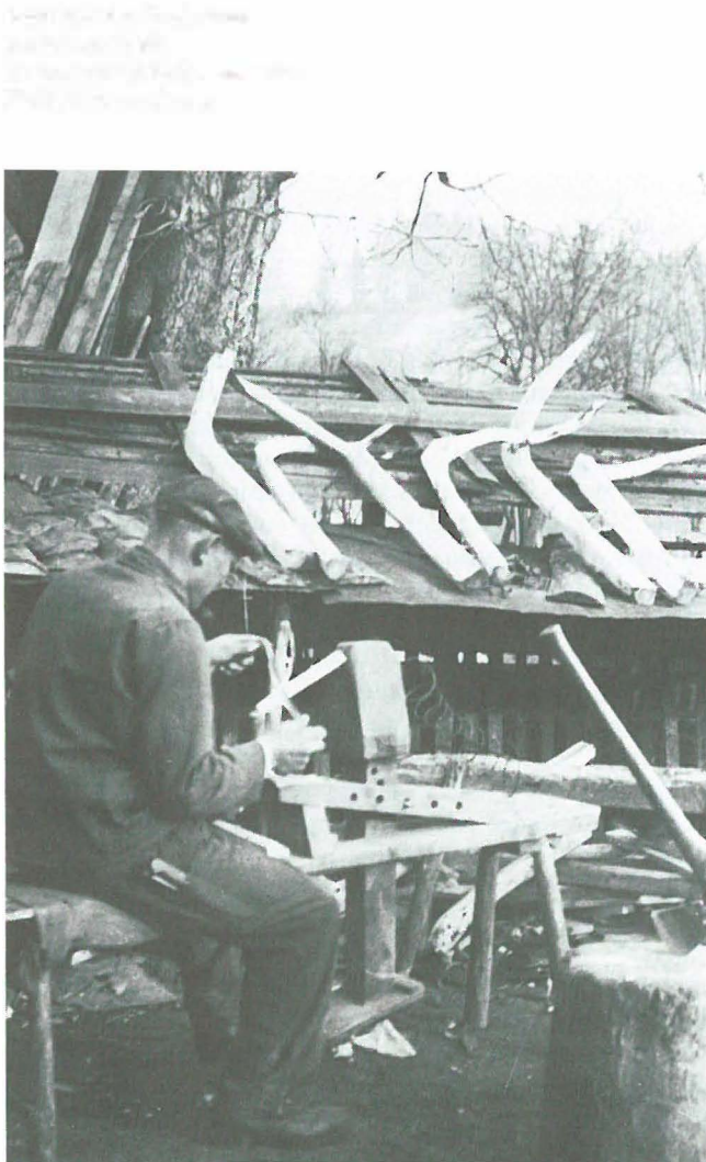
Abb. 1 Mit dem Ziehmesser werden die Holznägel zugeschnitten.
