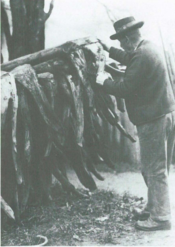
Abb. 12 Der Bootsbauer sucht die passenden Spanten aus.
