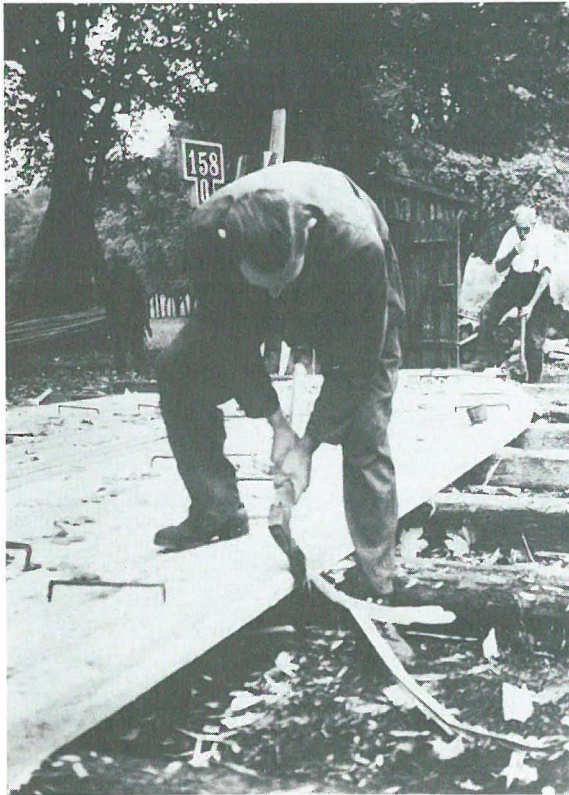
Abb. 4 Die oberste Seitenplanke am Bug (süddeutsch: Gransenblatt) wird angepaßt.
