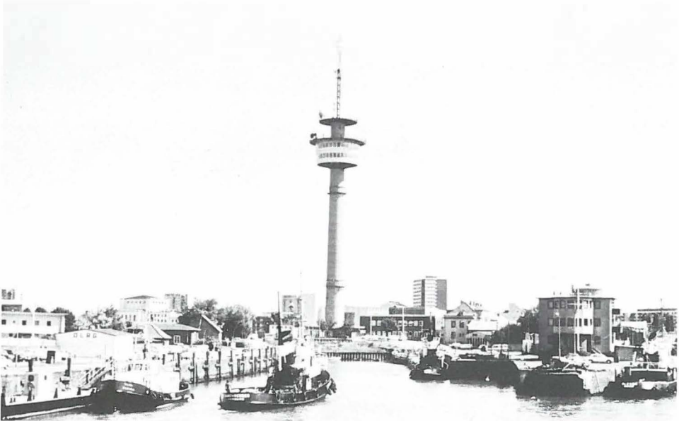
Abb. 17 Richtfunktturm Bremerhaven. (Foto vom Verf.)
