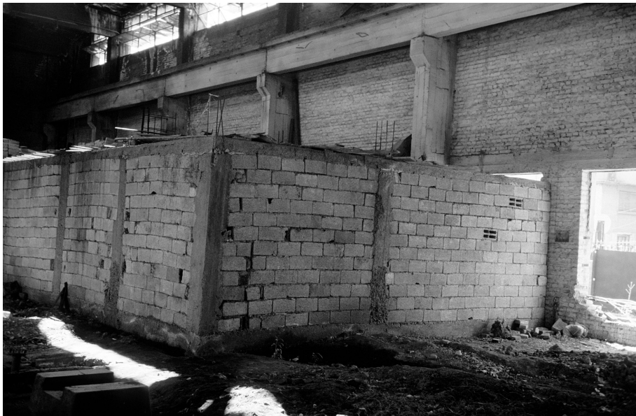
Foto 4: Eingebaute Squatterwohnungen in früherer Fabrikhalle des einstigen Traktorenkombinats (Tirana)
