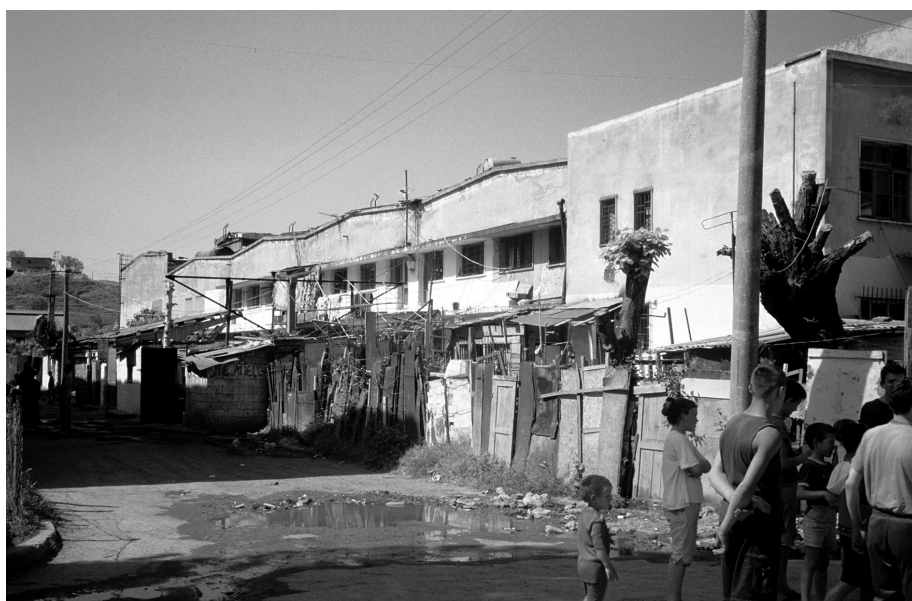
Foto 2: Squatterwohnungszeile in einem vormaligen Industriegebäude des früheren Traktorenkombinats (Tirana)
