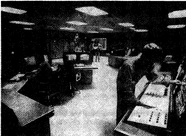
Leitwarten mit fortgeschrittener Prozeßleittechnik (Quelle: Magin, Wüchner 1987, S. 145)
