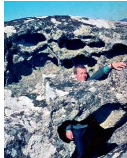
Durch Bröckellöcher (ital: tafoni ) ausgehöhlter Fels mit Flechten. Nach Durchfeuchtung bildete sich durch Austrocknung eine mineralisch verstärkte Rinde des Granitblocks; dahinter geht der Zerfall zu Grus weiter, der dann bei Schäden an der Rinde durch Regen und Wind ausgeräumt wird. Berg „Alto do Castelo“ südöstlich von Pisões/Viade de Baixo, Montalegre, März 1966.
