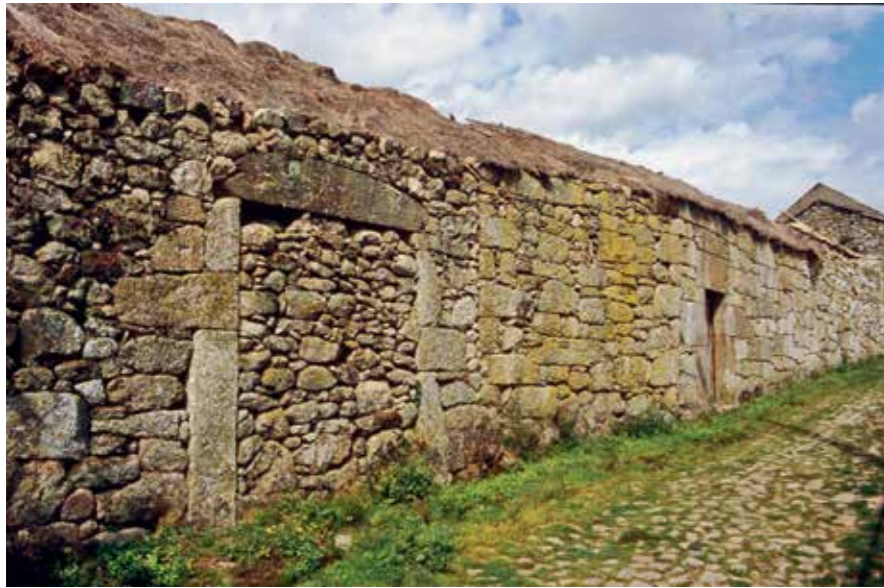
Reihe überwiegend nicht mehr genutzter Scheunen ( palheiros ) an der „Rua dos Carreiros“. Mourilhe, Montalegre, September 2008.
