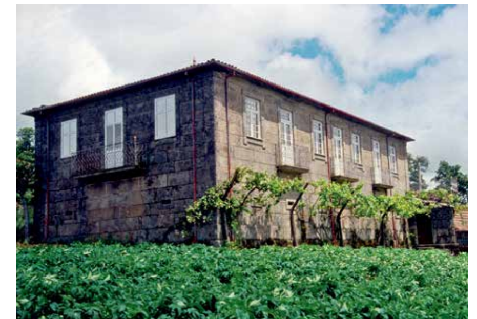
„Casa Grande“ von 1902 eines reich gewordenen Rückkehrers aus Lissabon, der dann einen landwirtschaftlichen Betrieb mit vielen Arbeitskräften führte. Nach Bankrott der Nachfahren von einem Pfarrer ersteigert. Parafita/Viade de Baixo, Montalegre, Juni 2007.
