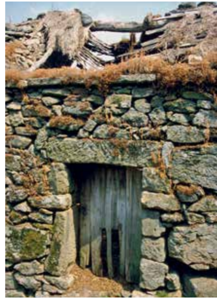
Ruine einer Scheune. Auf dem First noch Steine zur Befestigung von Ästen ( latas ) und Stroh ( colmo ). Mourilhe, Montalegre, August 1998.
