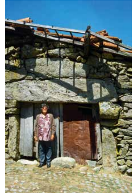
Aufgegebenes Wirtschaftsgebäude. Rahmung des Zugangs aus zyklischen Granitsteinen. Coimbró/Cerdedo, Boticas, August 2011.
